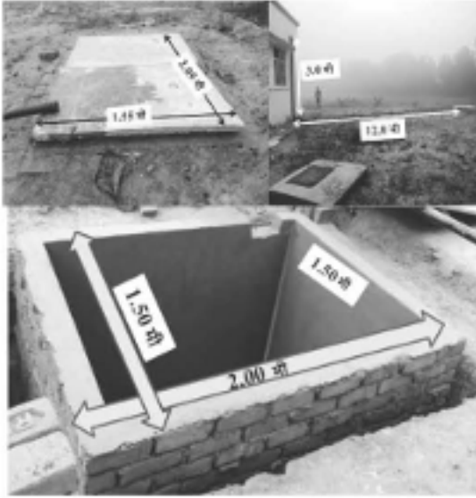
चित्र 9. मवन छत आधारित वर्षा जल संग्रहण सह संचयन प्रणाली
